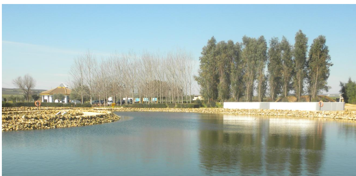
Vista parcial de los sistemas de depuración por lagunaje y filtro verde.
