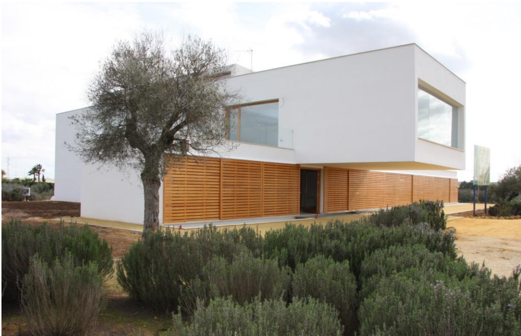
Imagen 4. Fotografía del nuevo Edificio Sede del CENTA, inaugurado en marzo de 2011
